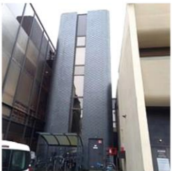
Ardoise Médiathèque Angers
