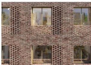
Résidence étudiante, Pierrefitte, BVF architectes, parement en brique de réemploi
